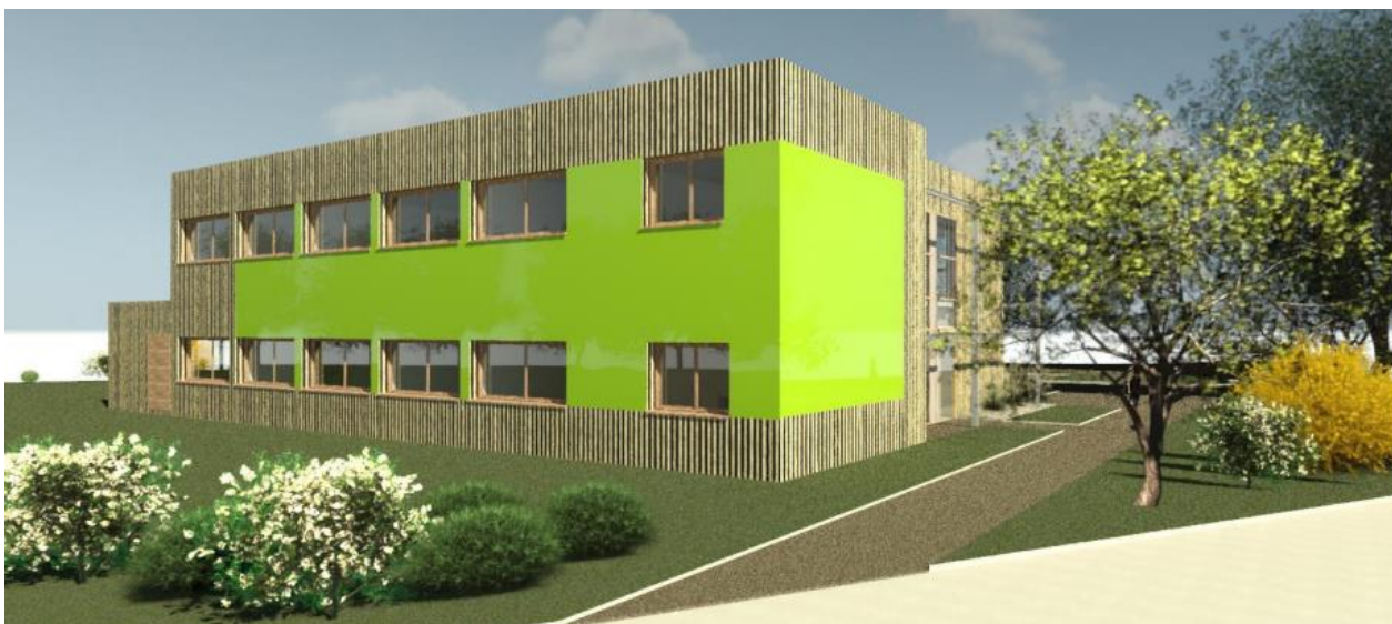
Vue trois-quarts arrière du bâtiment, côté Nord et Ouest
